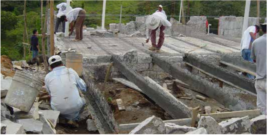
Construyendo los cimientos del Centro de Formación Kaltaixpetaniloyan . Archivo Tosepan .
